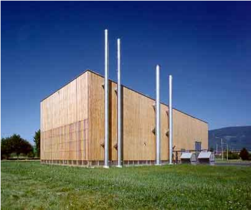
Fig. 4 Aussenansicht der Heizzentrale des Waffenplatzes in Bière.
